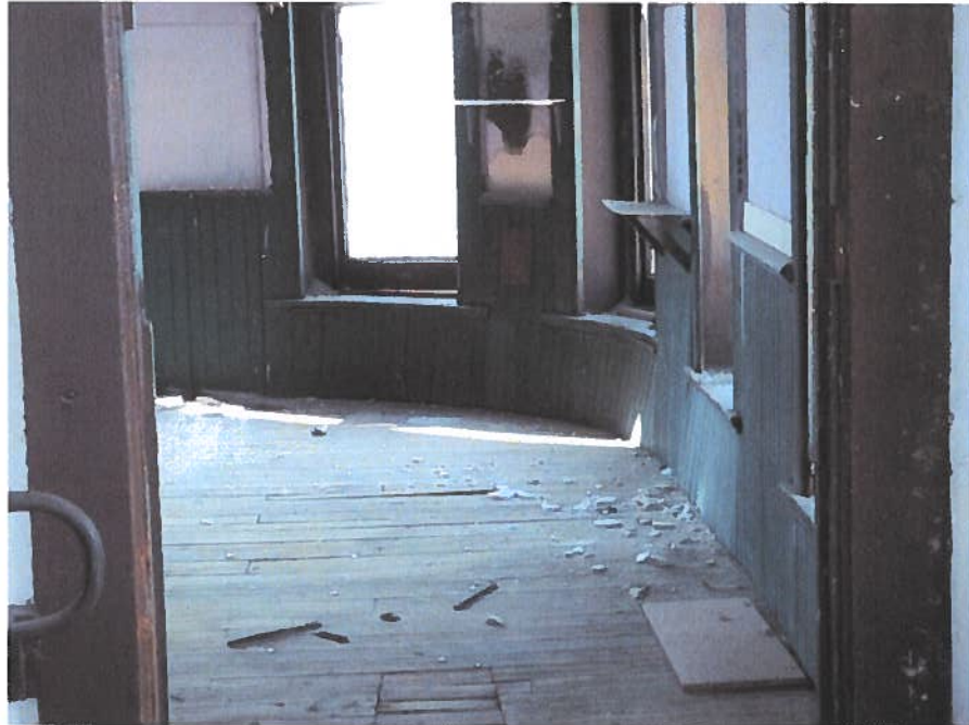
Buckling Wood Wall Slats
